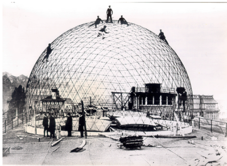
Domo en construcción.
